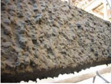
Şekil 3. Kuru karışım püskürtme beton uygulanarak güçlendirilmiş kiriş numunesinin görünümü
